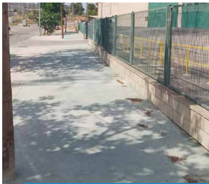
Hormigonado de aceras con la subvención municipal
